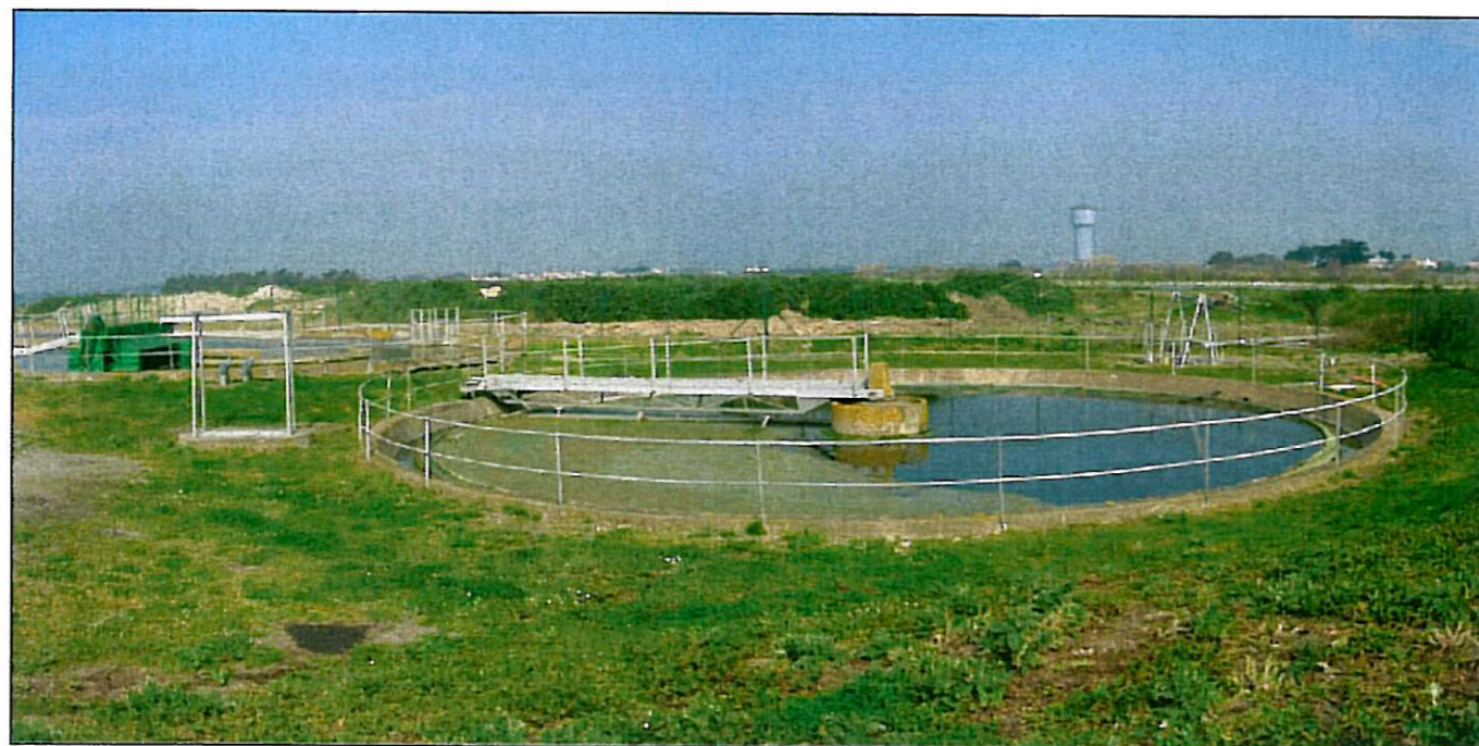
Situation avant travaux
